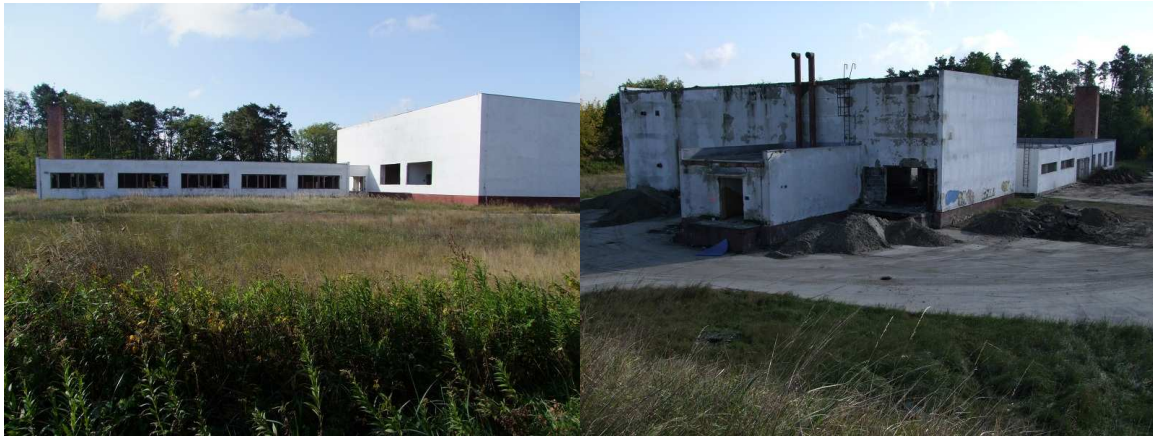
Obrázky – Vľavo = Predná časť hlavných stavieb, Vpravo = Zadná časť hlavných stavieb
